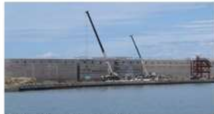
La diga Rewe3 nel porto di Civitavecchia con le celle attive
